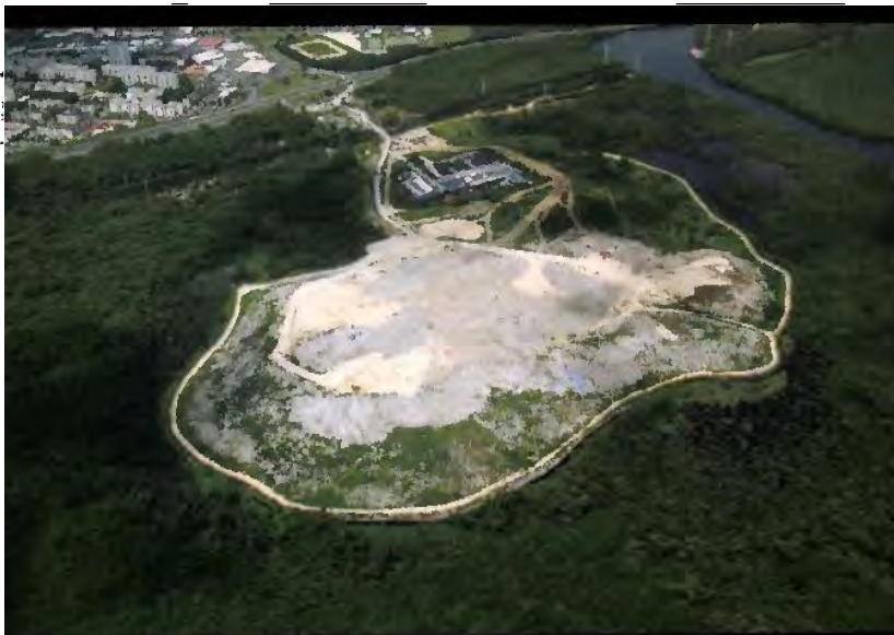
Des liquides issus de la fermentation des déchets de ce site de 36 hectares suintent dans la mangrove.
