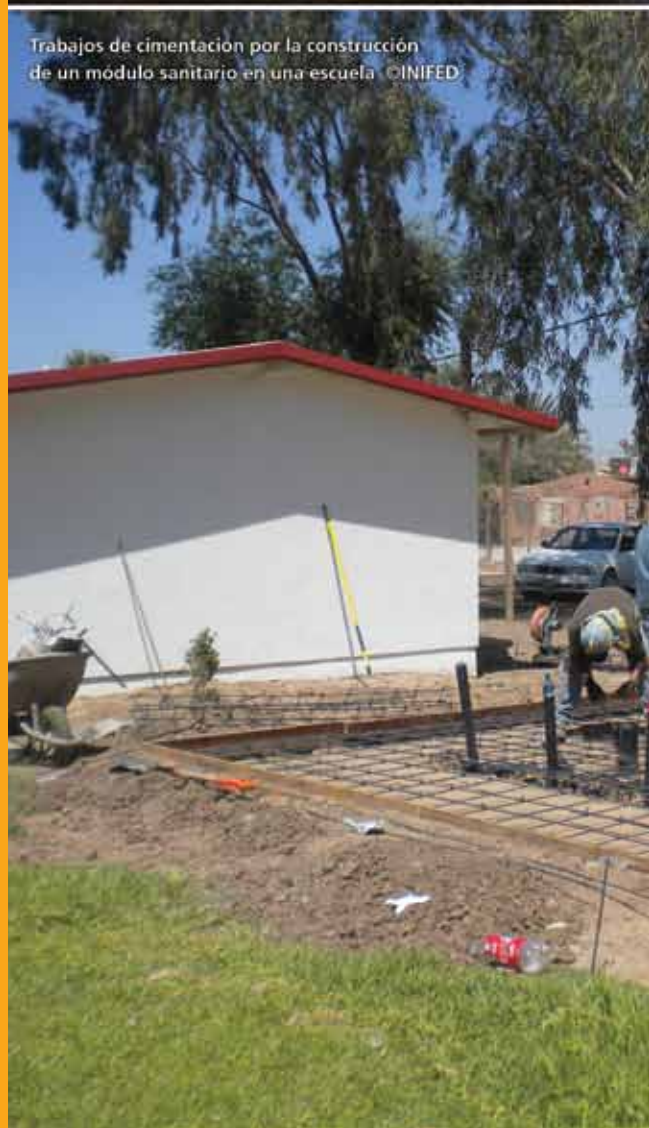
Construcción de cimentación en una escuela ©INIFED
