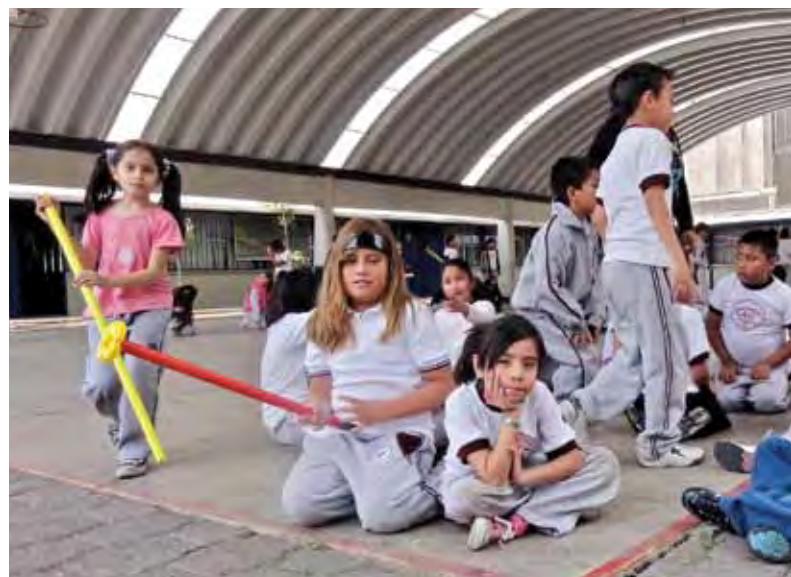
Figura 3.8 ▪ Cubierta de acero rolado en la Escuela Primaria Fernando Brom, Ciudad de México © R. Almeida
