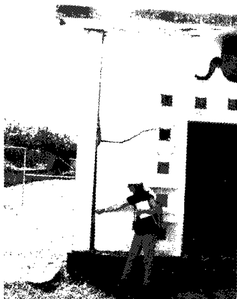
图 8.7 埃斯帕哈法托斯 (Espalhafatos) 的学校：石砌墙和钢筋混凝土构件之间发生分离
