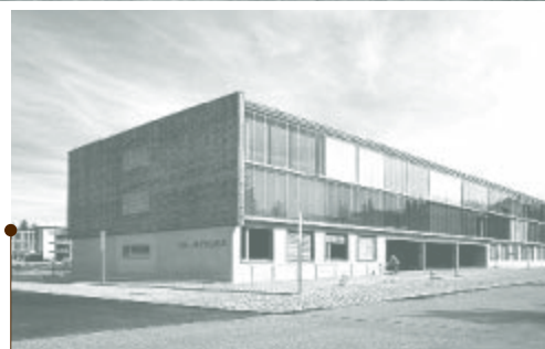
ÖKO – Hauptschule Strasswalchen , un collège à Salzbourg, qui associe des structures préfabriquées et des constructions en bois pour créer un environnement chaleureux
