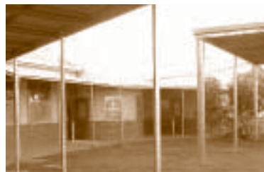
Façade avant de la nouvelle école photo prise de dessous les vérandas
