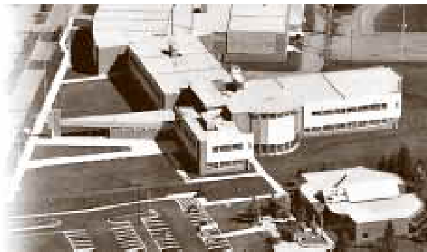
L'école secondaire l'Odyssee à Val-Bélair au Québec qui partage ses équipements sportifs avec la ville et, en échange, se sert de la bibliothèque municipale (en bas à droite).
