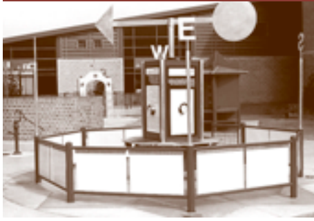
Une installation de traitement biologique des eaux usées Centre écologique de Boyne River, Toronto, Ontario
