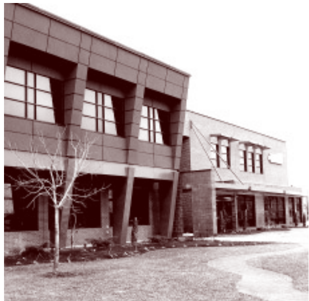
École Polymécanique de Laval, Canada
